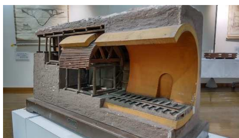
トンネル支保工
